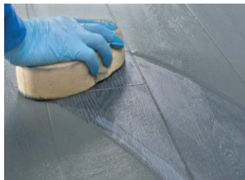
Reinigen en afwerken van voegen met een harde cellulose spons
