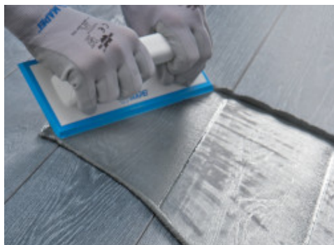
Ultracolor Plus met behulp van een voegrubber aanbrengen op porseleinen vloertegels met hout-effect
