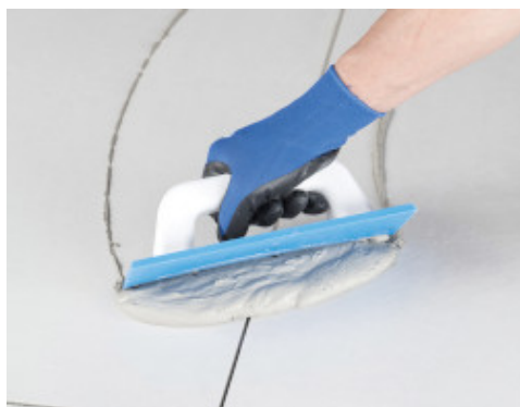
Ultracolor Plus met behulp van een voegrubber aanbrengen op porseleinen vloertegels
