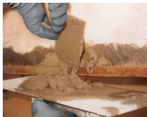
De voorkant van een balkon herstellen: aanbrengen van Planitop 400
