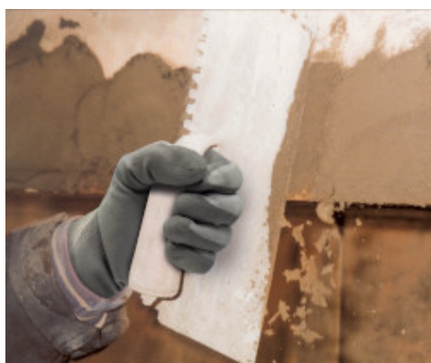
De voorkant van een balkon herstellen: afwerking
