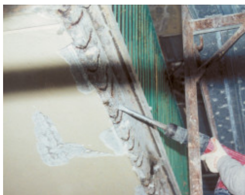
De voorkant van een balkon herstellen: voorbereiden van de ondergrond
