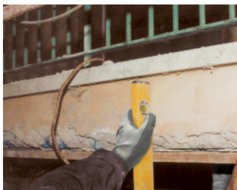
De voorkant van een balkon herstellen: plaatsen van een houten bekisting
