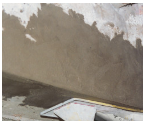
Plaatselijke restauratie van een betonnen balk
