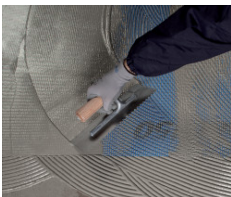
Plaatsen van Mapenet 150 op de nog natte eerste laag Mapelastic Turbo
