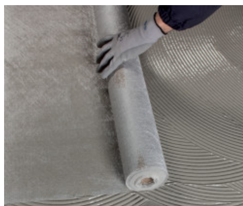
Plaatsen van Mapenet Sel op de nog natte eerste laag Mapelastic Turbo
