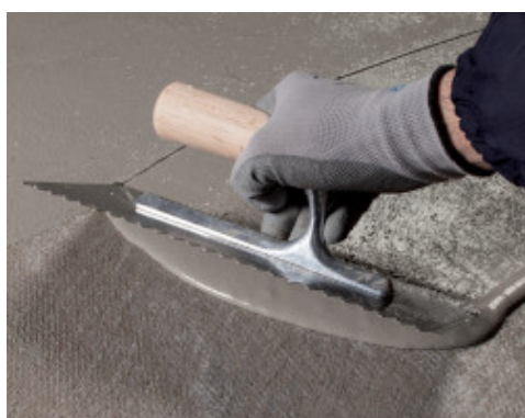
De tweede laag Mapelastic Turbo over de eerste laag versterkt met Mapetex Sel
