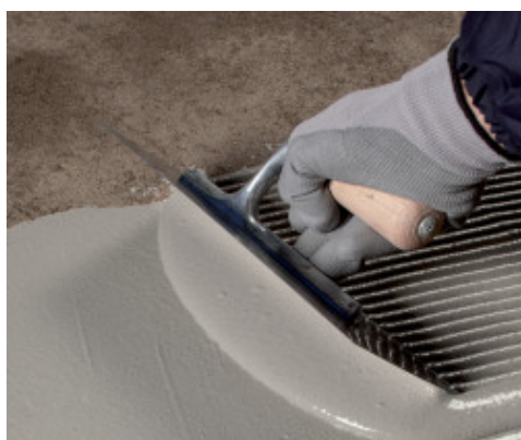
Aanbrengen van de eerste laag Mapelastic Turbo
