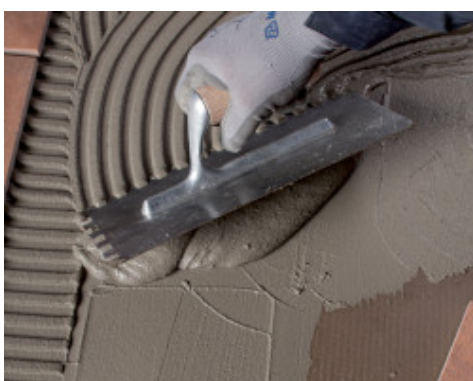
Plaatsen van Mapenet 150 op de nog natte eerste laag Mapelastic Turbo
