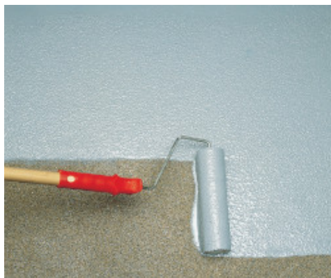
Met een roller aanbrengen van Mapecoat I 24
