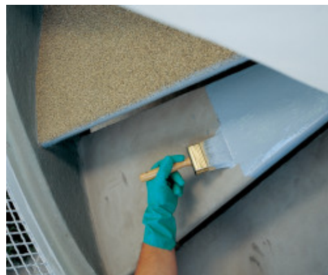
Aanbrengen van de eerste laag Mapecoat I 24 op beton
