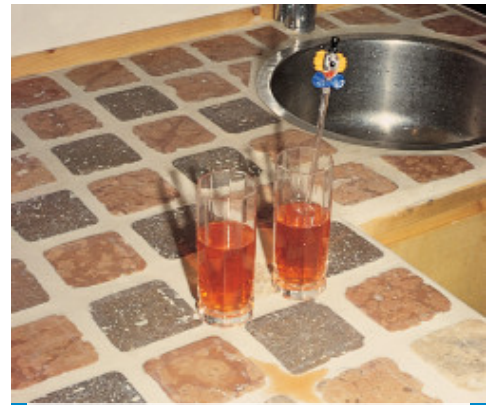
Voorbeeld van een verlijmd en gevoegd keuken werkblad
