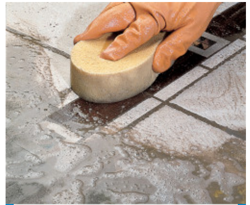
Met een spons afwerken van een keramische tegelvloer met houtinleg
