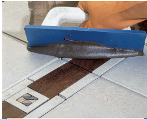
Met behulp van een voegbord voegen van een keramische tegelvloer met houtinleg
