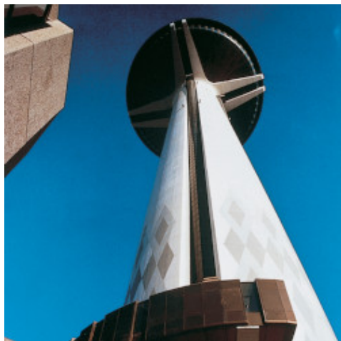
Porselein tegels verlijmd met Kerabond + Isolastic - Civic Center - North York Ontario (Canada)
